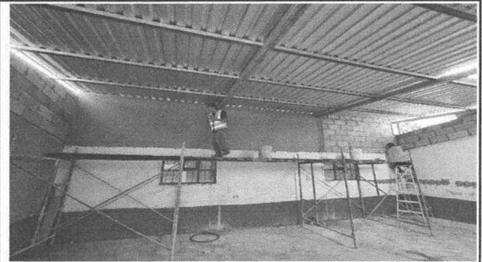
Foto 2: Levantado de pared para nivelar altura del modulo de trabajo numero 1
